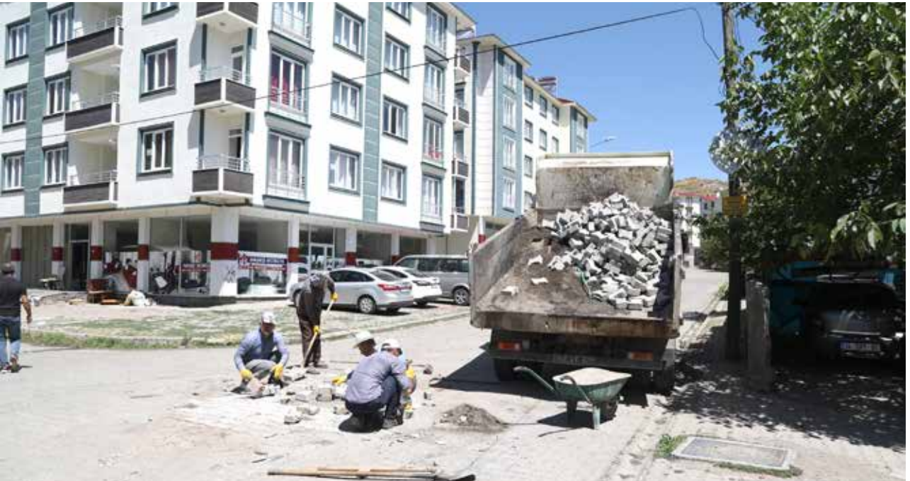
Belediyemiz yol ekiplerinin kilitli parke taşı onarım çalışması
