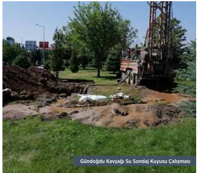
Gündoğdu Kavşağı Su Sondaj Kuyusu Çalışması
