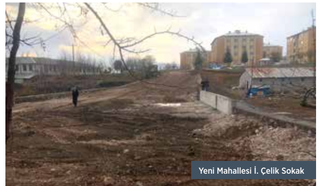
Simani Mah. Araç Köprüsü Yolun Son Hali
