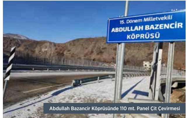
Abdullah Bazancir Köprüsünde 110 mt. Panel Çit Çevirmesi
