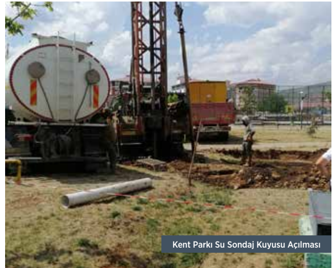
Kent Parkı Su Sondaj Kuyusu Açılması
