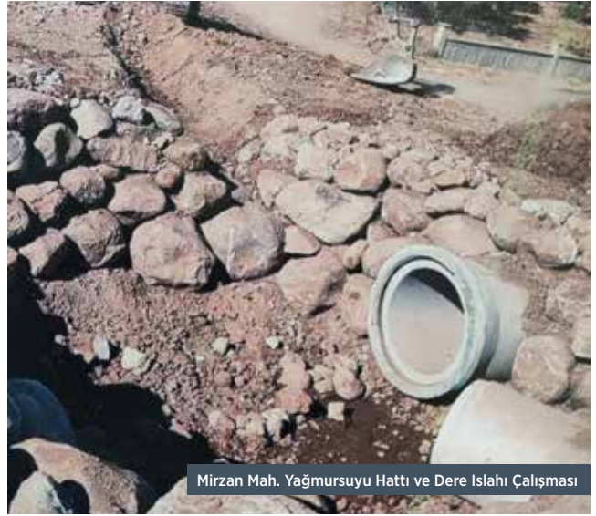
Mirzan Mah. Yağmursuyu Hattı ve Dere Islahı Çalışması
